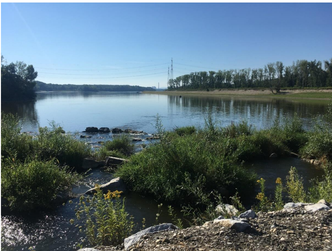
Fischaufstiegsanlage an der Altarmtraverse, Blick mit der Fließrichtung
