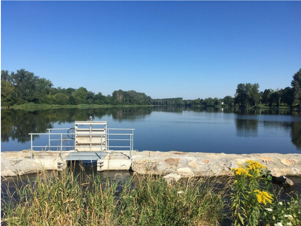
Fischaufstiegsanlage mit 1 von 3 Ausstiegsöffnungen, Blick gegen die Fließrichtung
