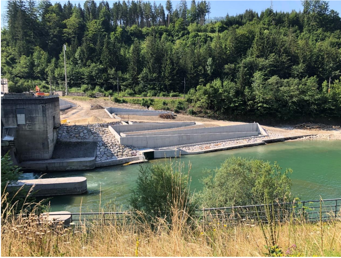
Wehr Eßling mit Fischwanderhilfe
