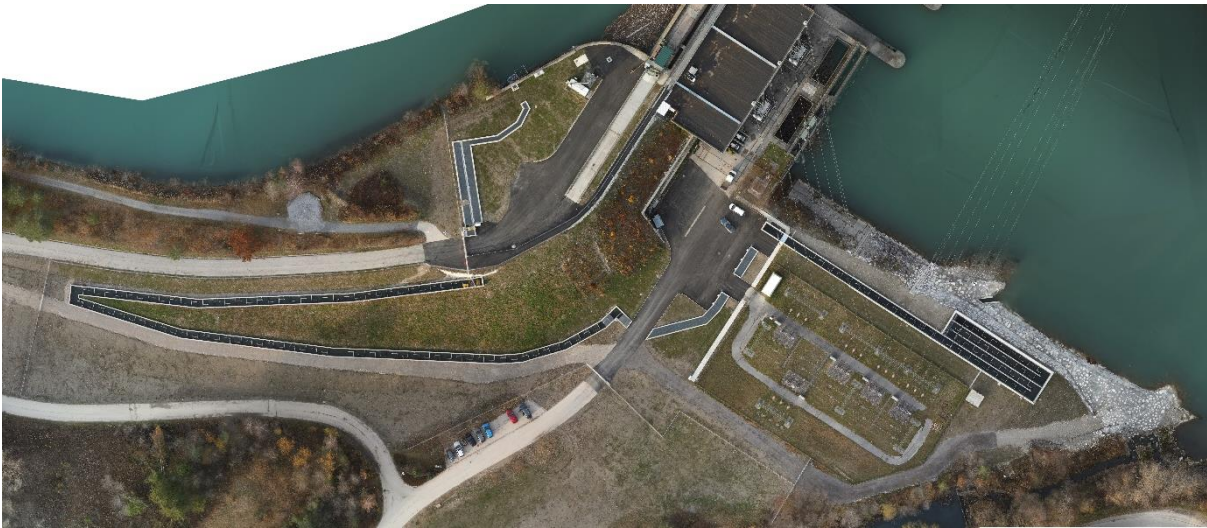
Fischwanderhilfe unterwasserseitig mit Hochwasserschutzmauer und oberwasserseitig mit Verteil-/Ausstiegsbauwerk mit Betreuungssteg und Totholzabwehr
