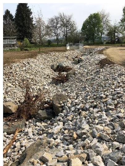
Abschnitt 2 KW Trattenmühle
