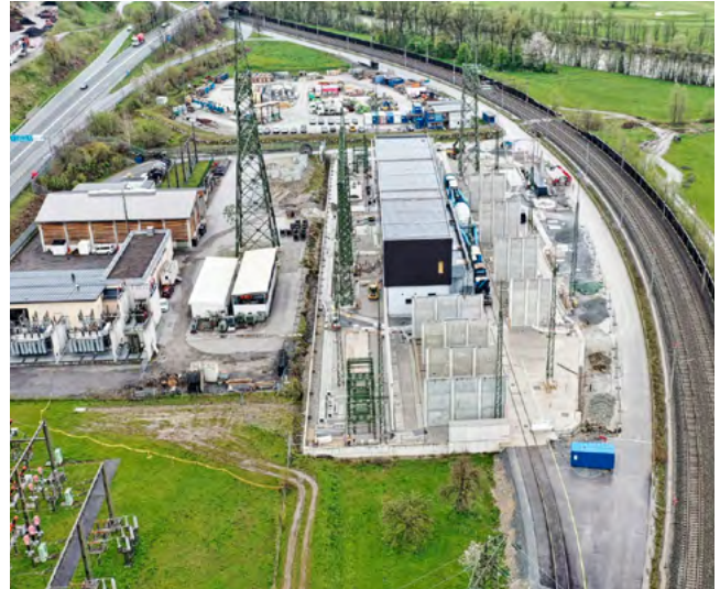
Im Zuge des Projekts 380-kV-Salzburgleitung wurde auch das Umspannwerk Pongau neu errichtet.
